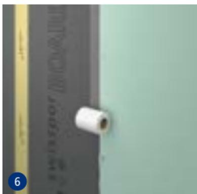
6 Hors zone humide, ponter les joints du panneau avec la bande de renfort swissporBOARD (autocollante).
