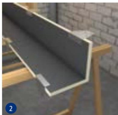
Repérer l'emplacement du support d'ancrage et le fixer au swissporBOARD élément d'angle.
