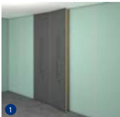
1 Pour la jonction avec les plaques de plâtre cartonnées, poser des plaques de construction swissporBOARD d'une épaisseur de 12,5 mm.
