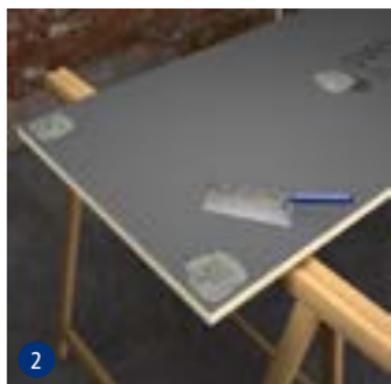
Appliquer la colle flexible au droit des ouvertures du panneau de construction swissporBOARD.
