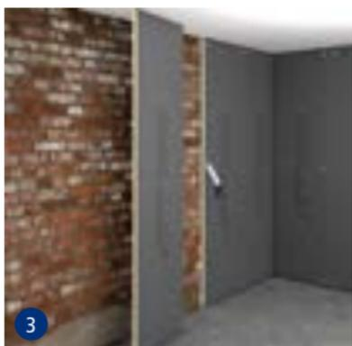
Pour le montage des panneaux, appliquer le mastic d'étanchéité et la colle hybride au droit des champs des panneaux à monter.
