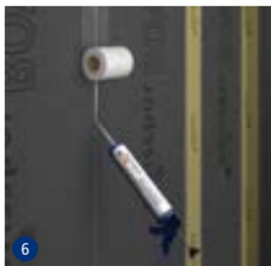
Ponter les joints des panneaux de construction avec la bande de renfort swissporBOARD (autocollante). Dans les zones humides, étanchéfier avec la bande d'étanchéité spéciale swissporBOARD et avec le mastic flexible 1K / Turbo 2K swissporBOARD.
