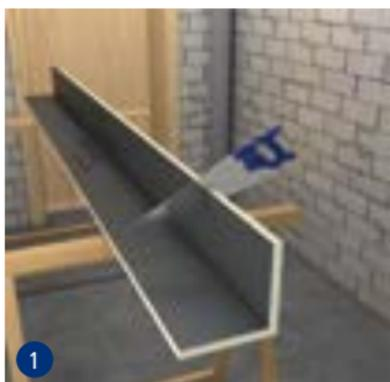
Scier l'élément d'angle swissporBOARD selon les dimensions souhaitées.
