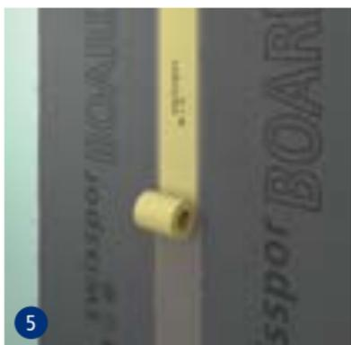
5 La bande d'étanchéité spéciale swissporBOARD ponté les joints pour une mise en oeuvre en zone humide et s'applique à l'aide du mastic flexible 1K / Turbo 2K swissporBOARD.
