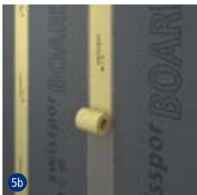
5b La bande d'étanchéité spéciale swisspor BOARD ponté les joints pour une mise en oeuvre en zone humide et s'applique à l'aide du mastic flexible 1K / Turbo 2K swissporBOARD.
