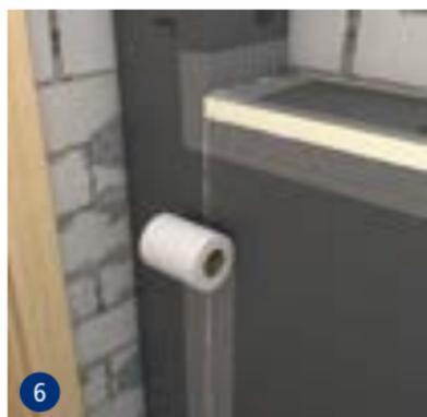
Ponter tous les joints de panneau à l'aide du mastic d'étanchéité et de la colle hybride swissporBOARD et d'une bande de renfort swissporBOARD (autocollante).
