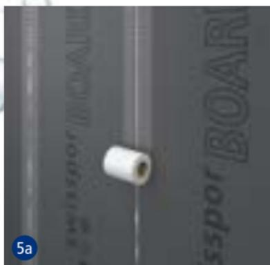
5a Fixer les joints des panneaux de construction avec la bande de renfort swissporBOARD (autocollante).
