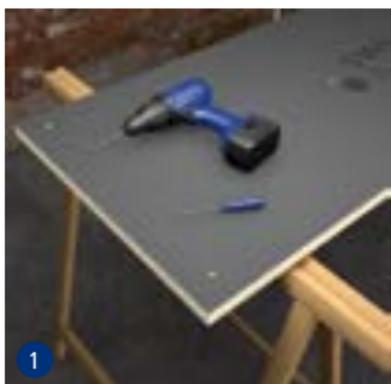
Pour la fixation ultérieure, percer le panneau de construction swissporBOARD, 5 trous par m<sup>2</sup>.
