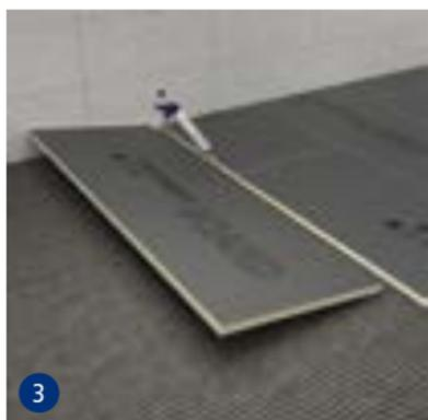
3 Encoller les panneaux de construction swissporBOARD sur le support à l'aide de la colle et du mastic hybride swissporBOARD pour le jointage des panneaux entre eux.
