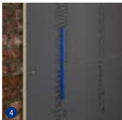
Ajuster tous les panneaux de construction swissporBOARD de manière homogène les uns par rapport aux autres.
