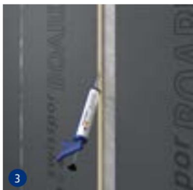
3 Le mastic d'étanchéité et la colle hybride swissporBOARD permettent de coller et de sceller les arêtes du bord à souder.
