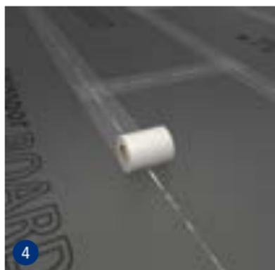
4 Ponter tous les joints des panneaux à l'aide de la bande de renfort swissporBOARD (autocollante). Dans les zones humides, étanchéfier à l'aide de la bande d'étanchéité spéciale swissporBOARD et à l'aide du le mastic flexible 1K / Turbo 2K swissporBOARD.
