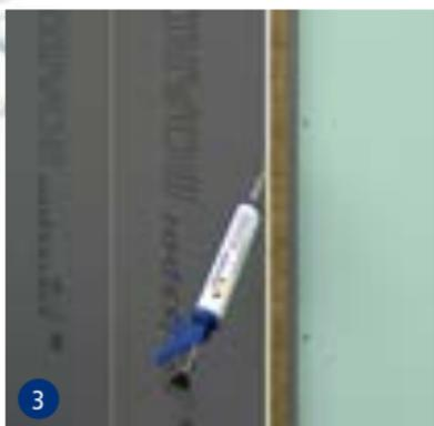
3 Coller et sceller également les champs des bords à souder les uns aux autres à l'aide du mastic d'étanchéité et de la colle hybrides swissporBOARD.
