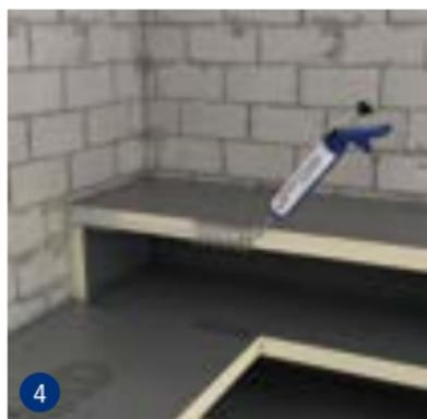
Coller et sceller toutes les arêtes du bord à souder les unes aux autres à l'aide du mastic d'étanchéité et de la colle hybride swissporBOARD.
