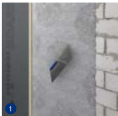
1 Appliquer uniformément la colle souple S1 swissporBOARD sur les surfaces planes à l'aide d'une truelle dentée.
